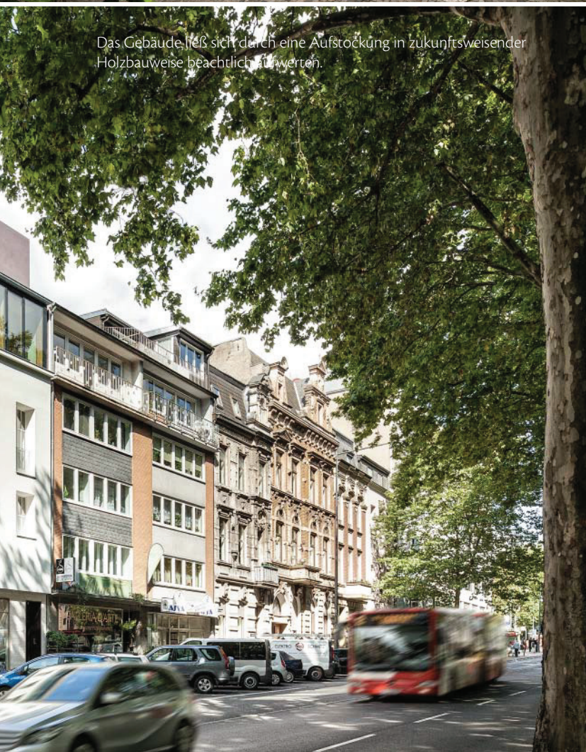
Individuelle Holzaufstockung über zwei Geschosse
