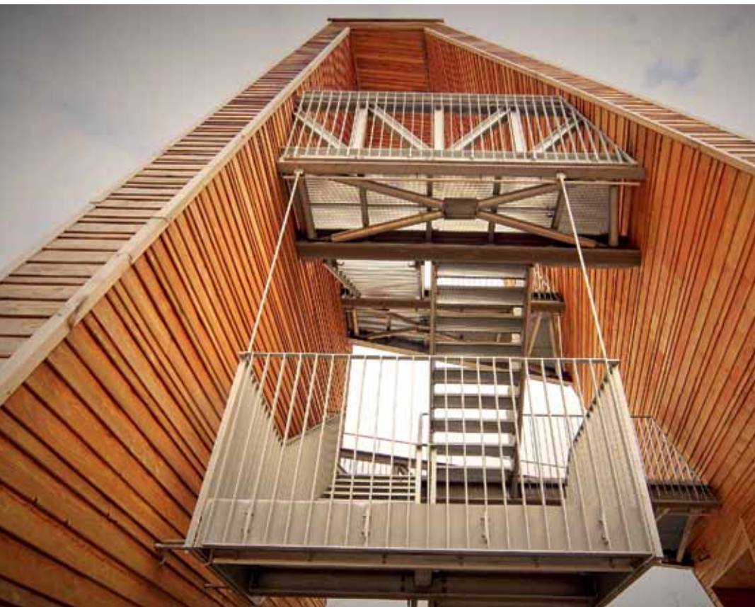
Der Aussichtsturm besteht aus Holz und ist wie der Rest des Gebäudes mit einer Lärchenschalung versehen. Die Aussichtsplattformen sind als Stahlkonstruktionen ausgeführt.
