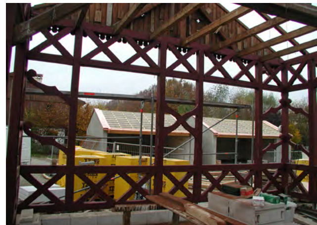
? Nach Fachwerk-Sanierung begann das Verlegen der Porenbetonsteine
