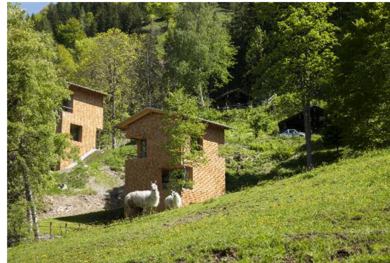
Hüttentürme im Gelände
