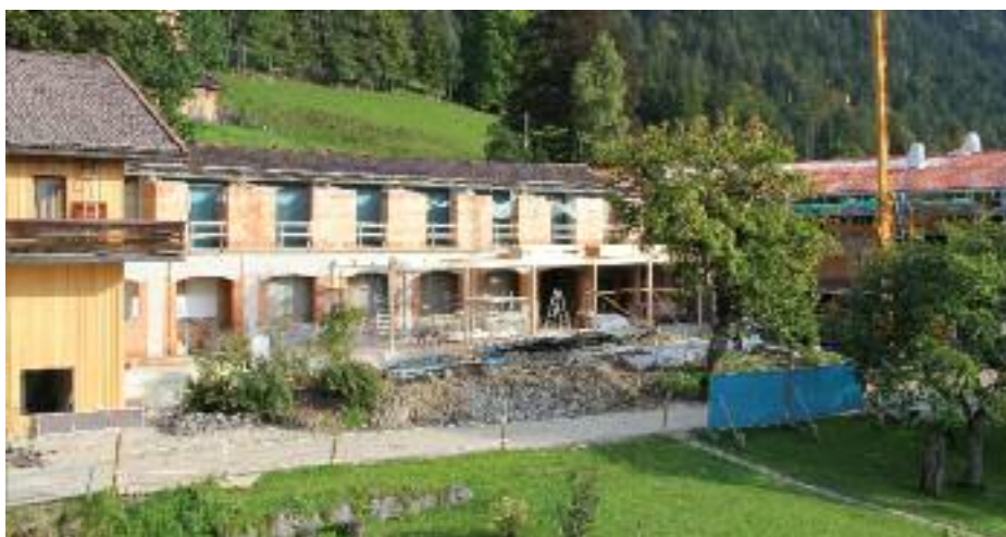
Fertige Situation und Baustellenansicht Bereich Orangerie
