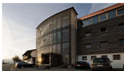
Das Haupthaus ist dem Corpus alter Allgäuer Bauernhäuser nachempfunden. Weitere, hinzugefügte Materialien sind Glas, aufgearbeitetes Altholz, Naturstein, Lehmputz, Weidengeflecht und Produkte aus der Region wie handgewebtes Leinen oder Filz.
