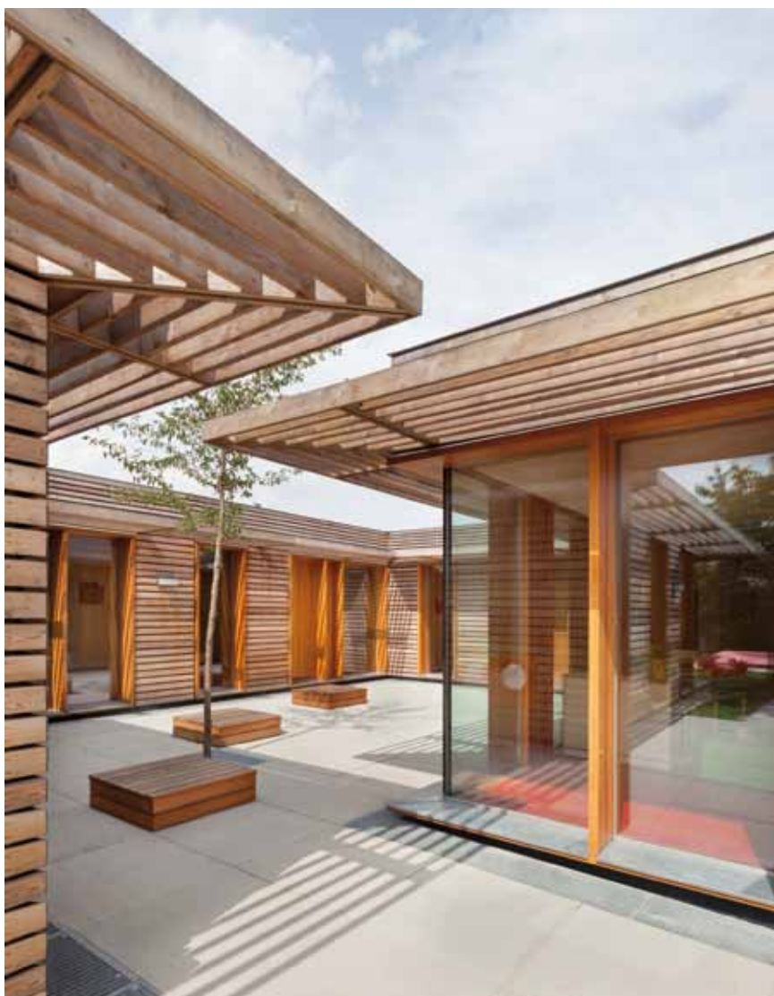
Schon von Weitem ein Hingucker: durch und durch aus Holz ist die neue Kinderkrippe in Polenfeld. Um den 57 Quadratmeter „kleinen“ Innenhofe reihen sich vier Holzgebäude.
