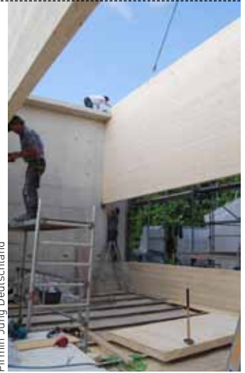
Bis auf einige wenige Ziegelwände sind alle tragenden Bauteile als Holzbau ausgeführt
