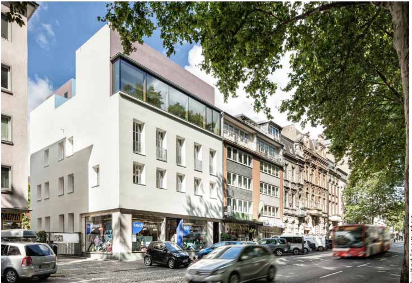
Das Gebäude erhielt durch die Aufstockung in Holzbauweise eine deutliche Aufwertung
